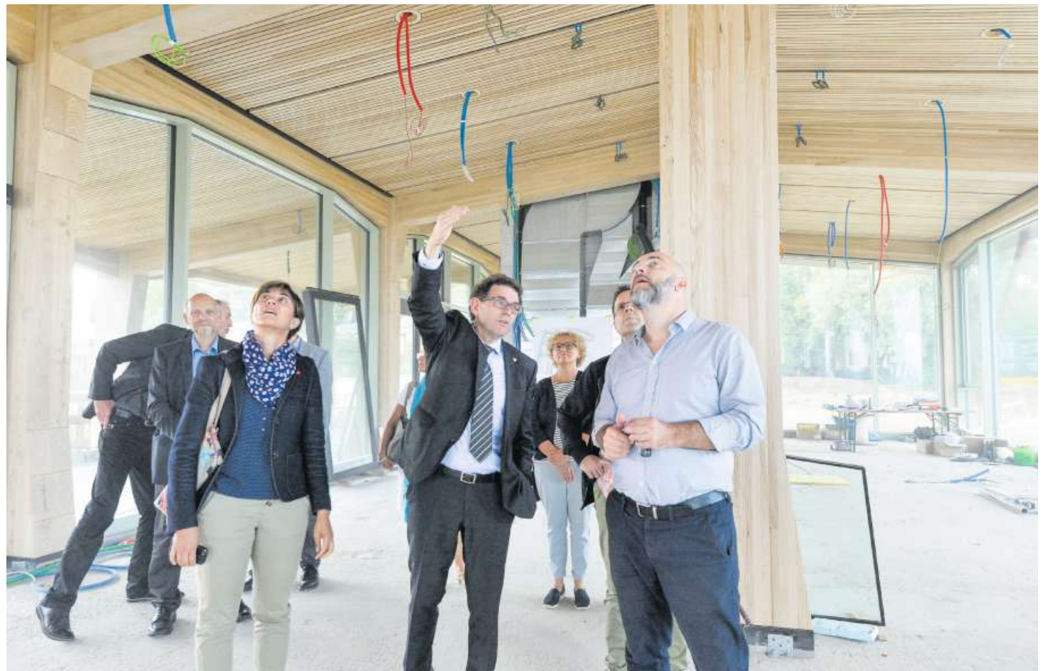
Die Regierungsräte Monika Knill und Jakob Stark lassen sich von Architekt Lukas Imhof über die Baustelle im Ekkharthof führen. Hier stehen sie im neuen Gastronomiegebäude des Sonderschul- und Wohnheims. Bild: Donato Caspari
